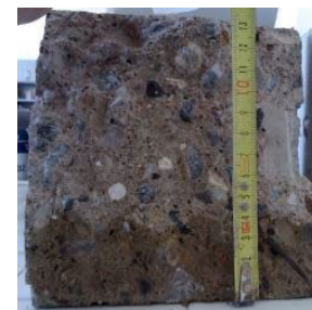
Cls senza Aeternum con additivo impermeabilizzante
